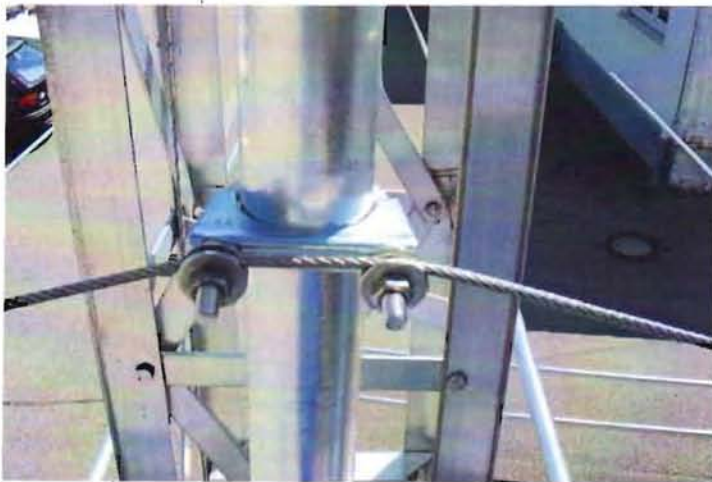
Zentrale Boomabspannung am Drehrohr Centre boom truss mounted on the mast
